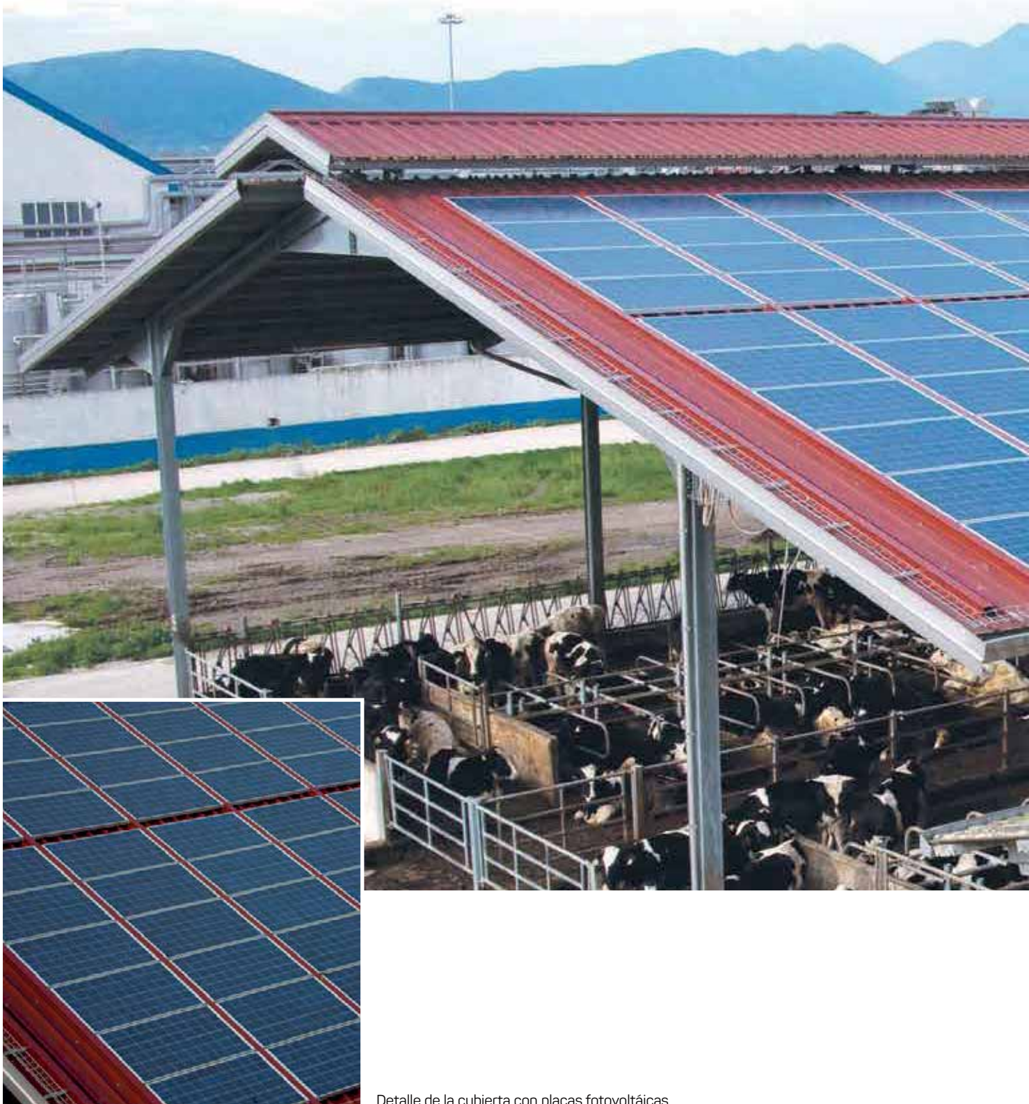
Detalle de la cubierta con placas fotovoltaicas
