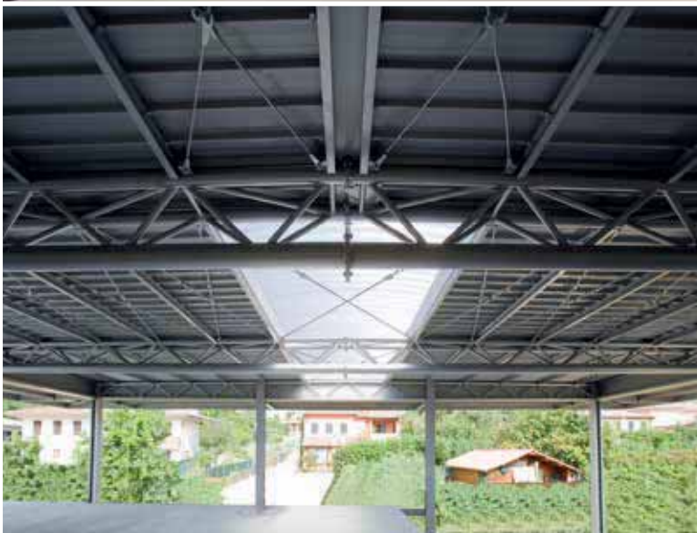
Detalle del soffito la cubierta
